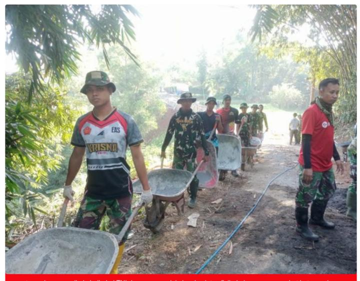
tampak semua pihak baik dari TNI dan warga melakukan kegiatan fisik dari pengecoran rabat beton sedang mengantri untuk mengangkat bahan cor rabat beton
